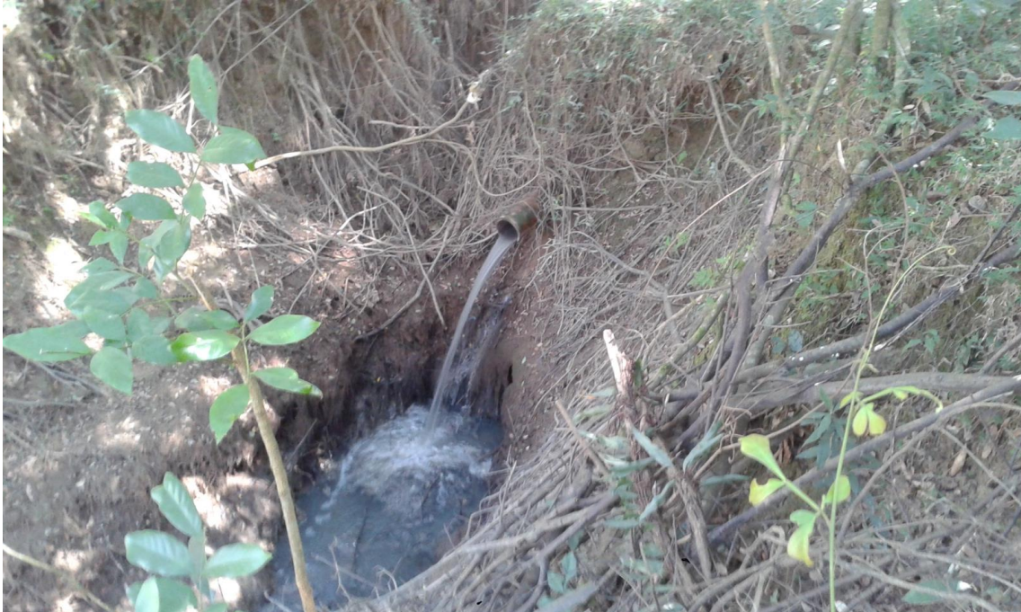
Figura – Lançamento esgoto bairro Faisqueira
