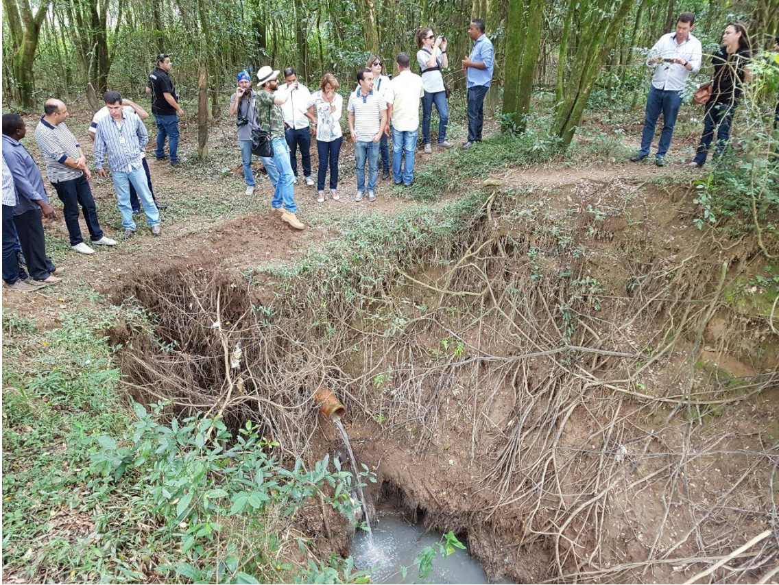
Figura – Ponto de lançamento de esgoto no Rio Sapucaí Mirim, no bairro Faisqueira (ponto 24 no mapa)
