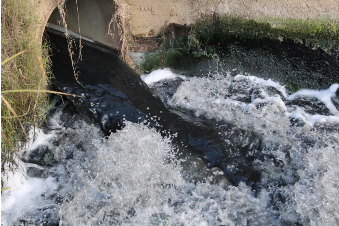
Figura – Lançamento de efluente no Rio Sapucaí Mirim, proveniente da ETE da Copasa no Bairro BH, dia 16/07/2017, em torno das 17h.
