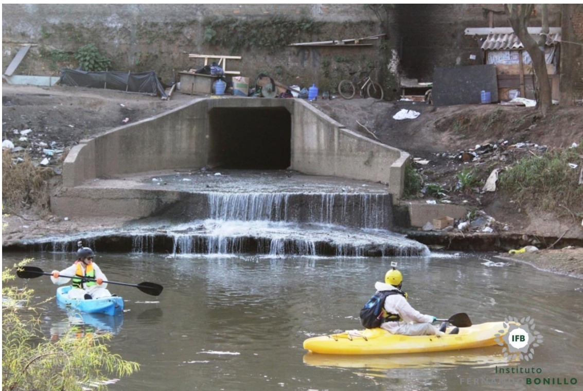
Figura – Ponto crítico após lançamento de esgoto na rede pluvial do bairro Jardim Yara
