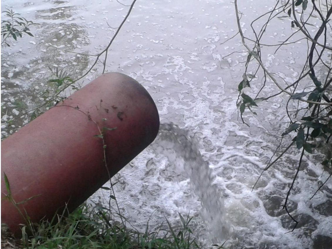
Figura – Lançamento de esgoto no Rio Sapucaí proveniente da ETE Cidade Jardim (ponto 25 no mapa)
