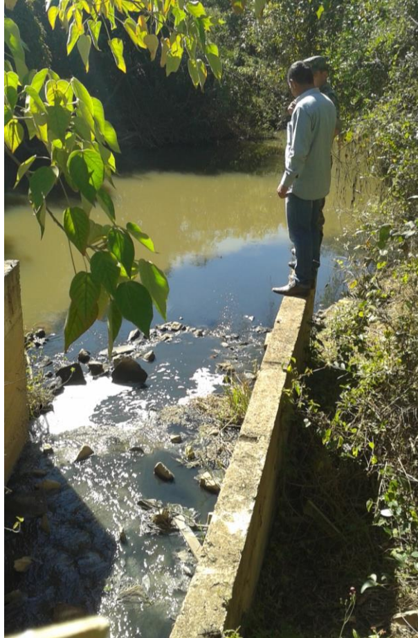
Figura – Ponto de lançamento de esgoto no Rio Mandú e pluma negra se espalhando pelo rio
