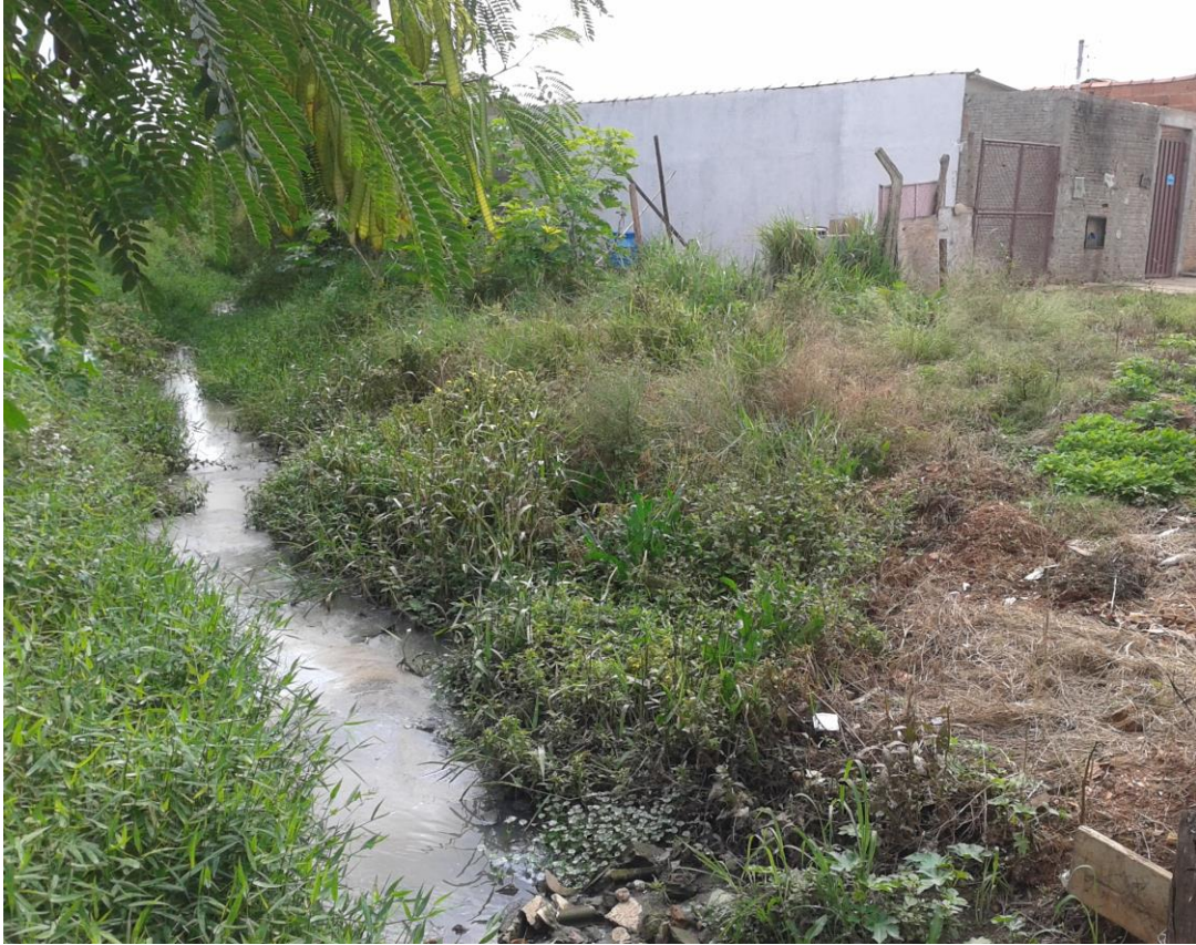
Figura – Lançamento de esgoto indevido no bairro São Geraldo
