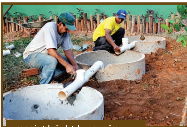
...para a instalação de tubos e conexões
