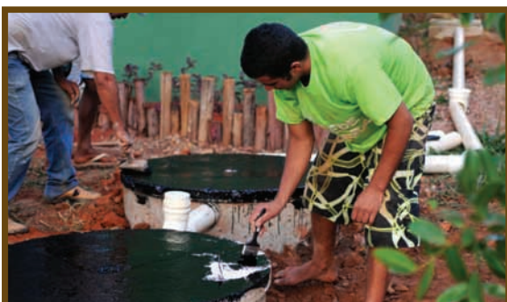
As tampas das duas primeiras caixas devem ser pintadas periodicamente de preto para garantir alta temperatura
