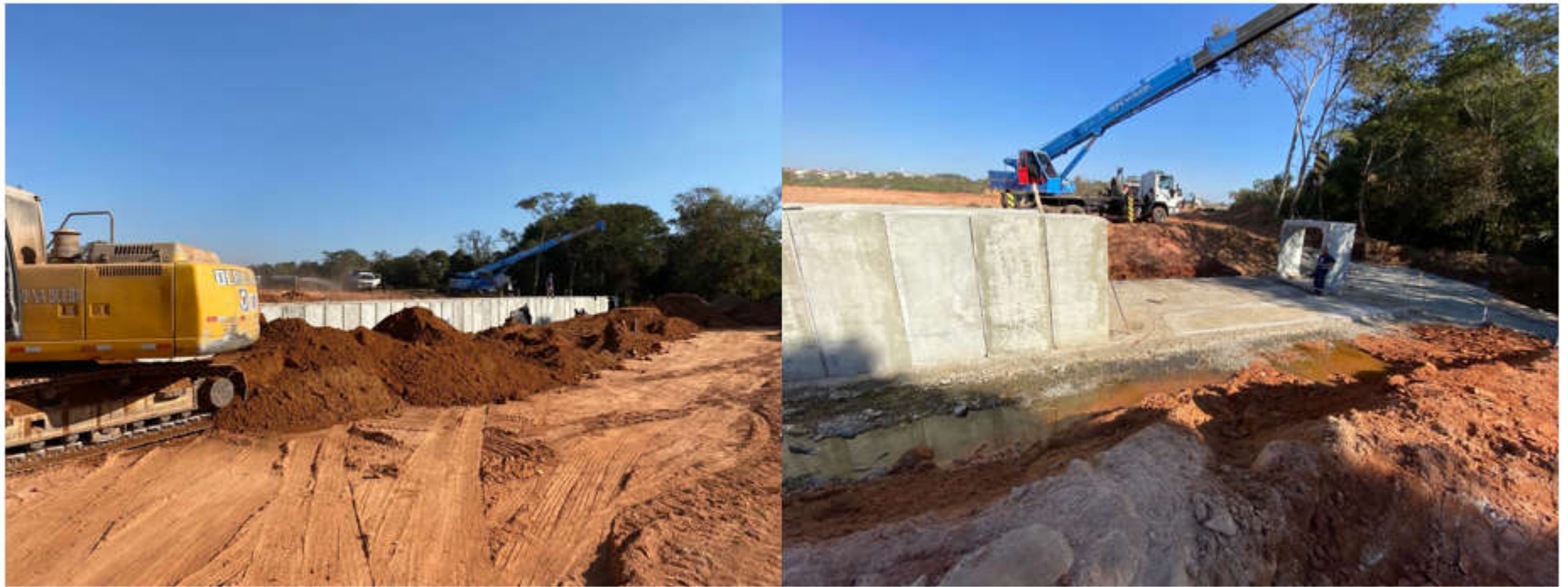
Figura 2 – Execução de bueiro celular |
