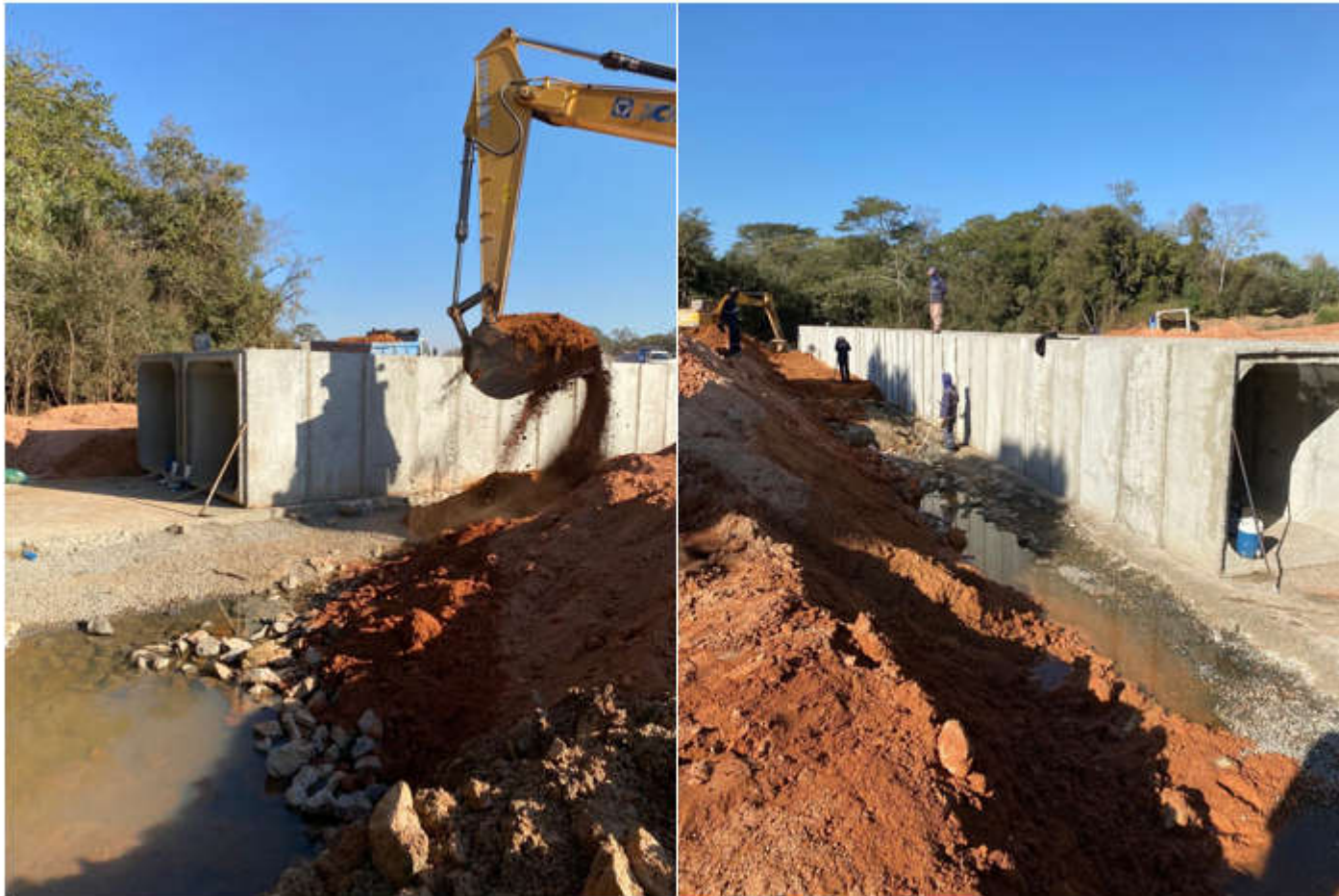
Figura 1 – Execução de bueiro celular
