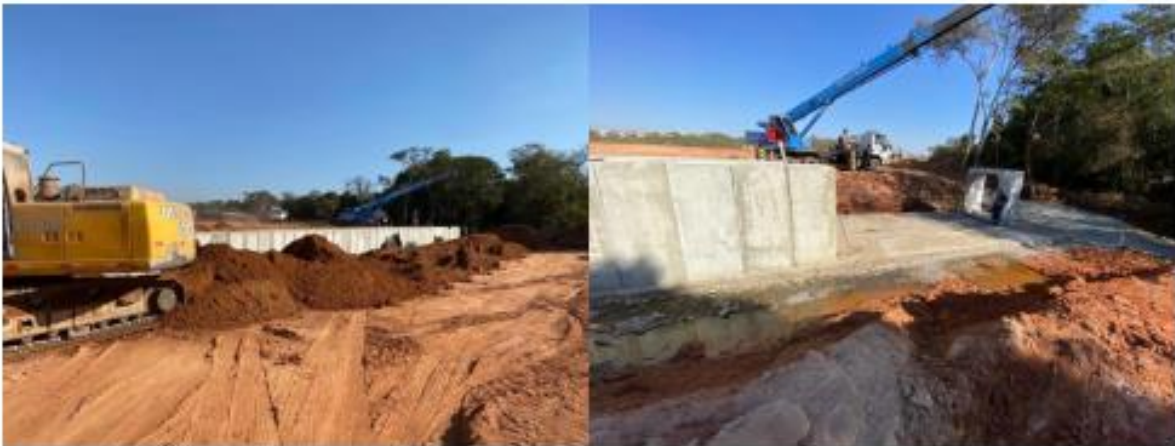
Figura 2 – Execução de bueiro celular
