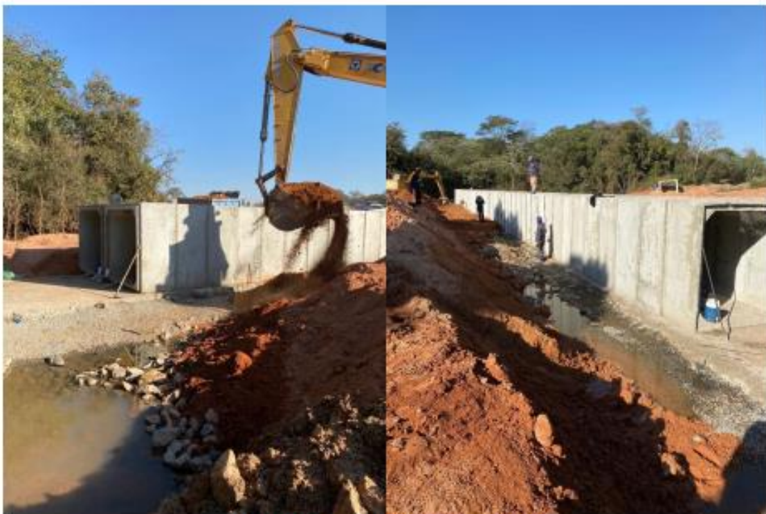
Figura 1 – Execução de bueiro celular
