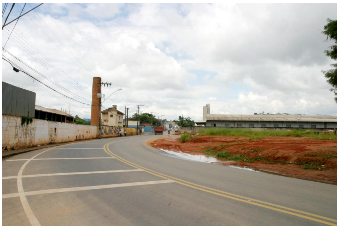
FIGURA 8.17. Principal via de acesso do bairro Faisqueira Rua Antônio Scodeler
